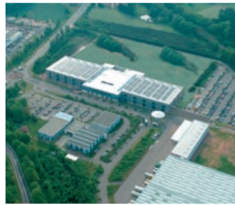
Von links nach rechts: Brennstoffzelle „HotModule“ mit Eurozellstapel, Photovoltaikanlage und Produktionsgebäude Festo Werk St. Ingbert
