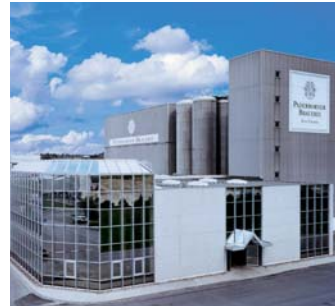
Von links nach rechts: Kompressorsteuerung im Maschinenraum der Paderborner Brauerei, Kompressor, Außenansicht der Paderborner Brauerei.
