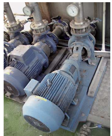
Bild 2: Alte Kühlwasserpumpen.
