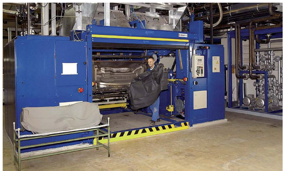
Produktion von Formhäuten bei der Benoac Fertigteile GmbH, im Hintergrund einige Pumpensysteme.
